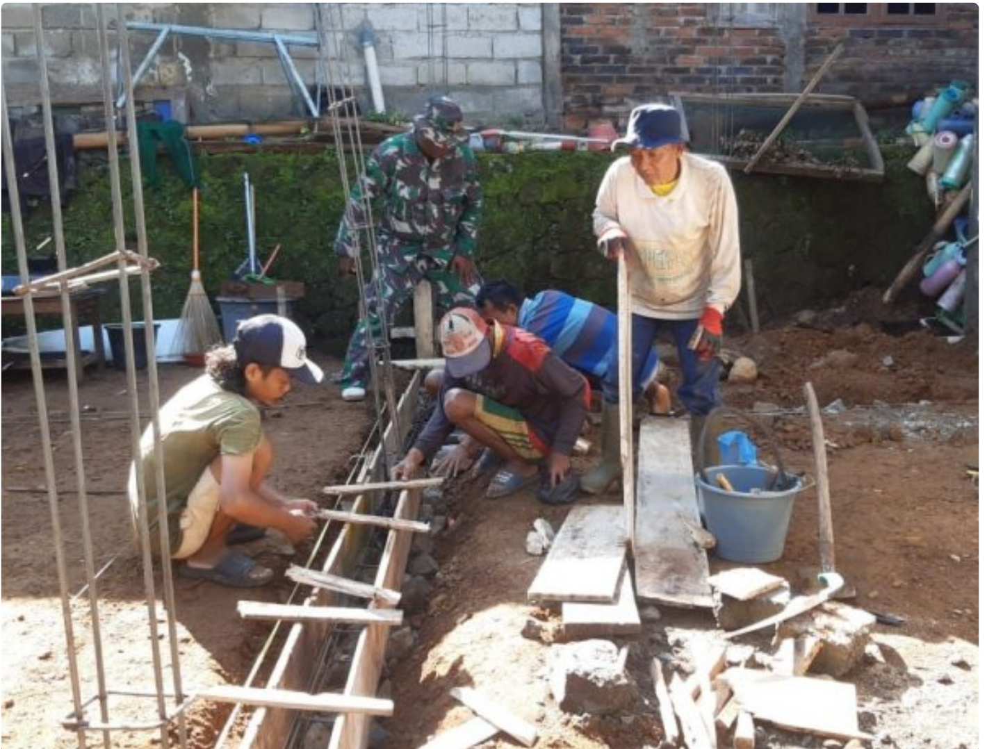
Pemasangan Bekisting Balok Sloof
